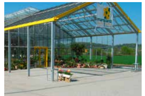
Der alte Eingang vor dem Umbau
