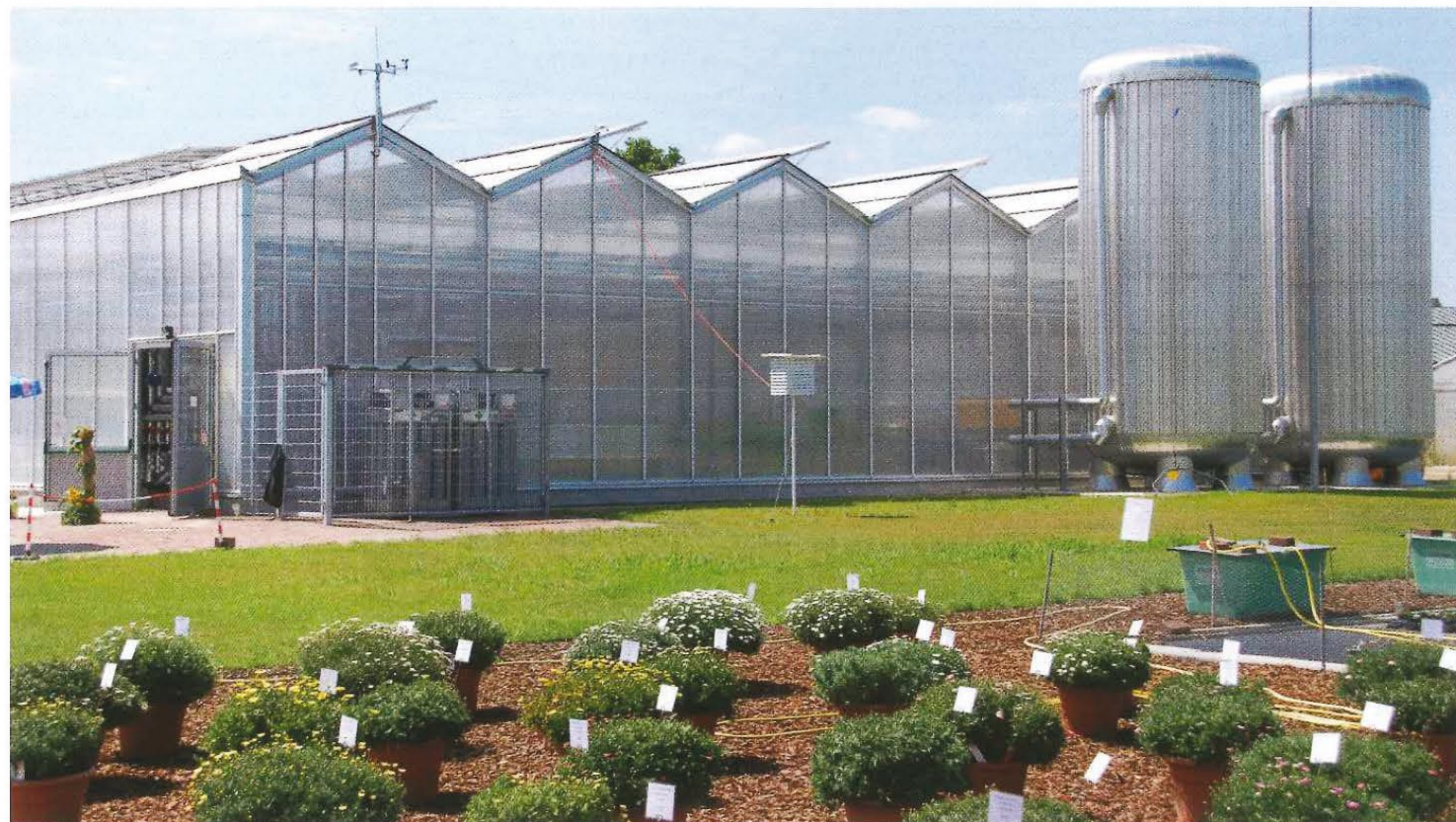
Blick aus nördlicher Richtung auf das Niedrigenergiegewächshaus Hannover mit den Pufferspeichertanks. Two water buffer storage tanks store excess heat from the greenhouse.
