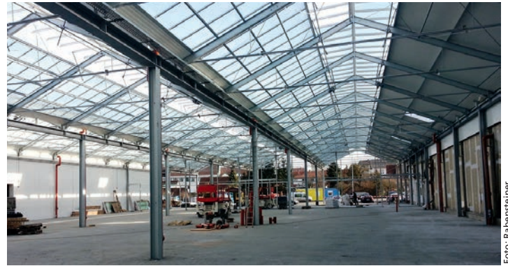
In Feldbach/Stmk wird für die Lieb-Gruppe ein 2.400 m 2 großes Gartencenter umgesetzt. Weite Stützenabstände und eine hohe Bauweise kennzeichnen dieses Gartencenter
